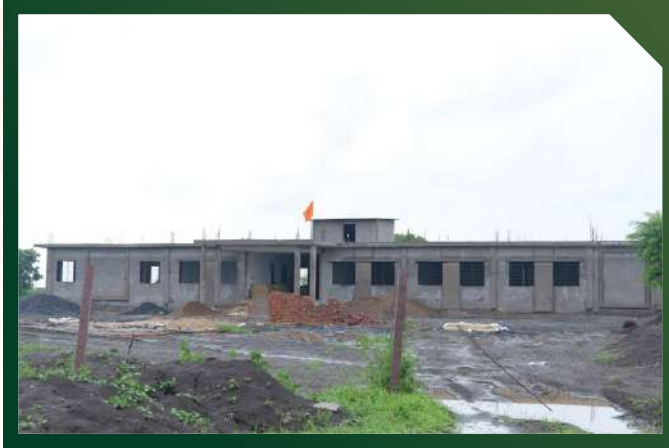
कॉलेज (Under Construction) - ऋषि दयानंद सरस्वती शिखा संस्थान, बूढ़ा
